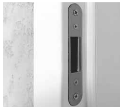
zaczep zamka magnetycznego w ościeżnicy
