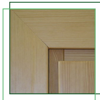
PROSTA PRZYCIĘTA POD KĄTEM 45 ST.
