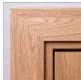
standardowe łączenie opasek pod kątem 45°
